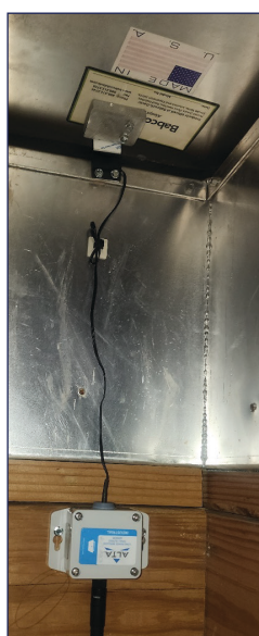
Roof Hatch door sensors
